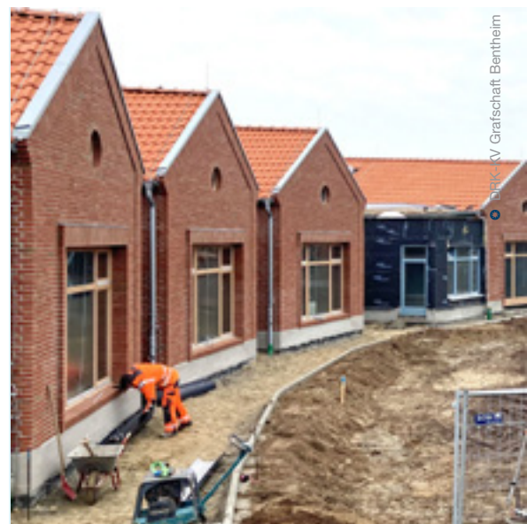
Hier entsteht die neue Kita in Neuenhaus.
