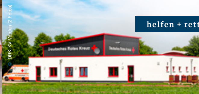
Außenansicht der neuen Rettungswache Morsum.
